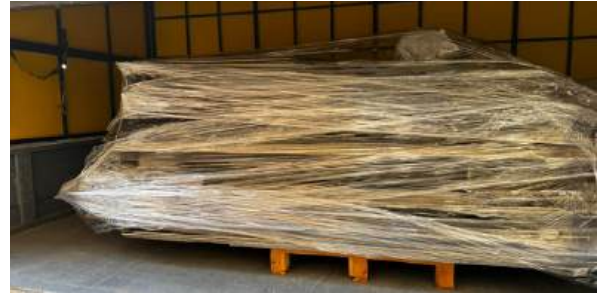
Asbest Söküm Çalışmaları
