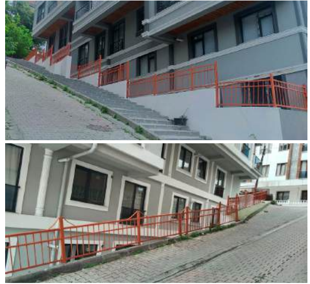
Yol ve Merdiven Korkuluk Yapım Çalışmaları
