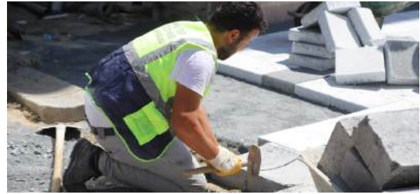
Yol Bakım Onarım Çalışmaları
