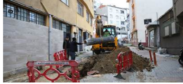
Yağmur suyu Yapım Çalışmaları
