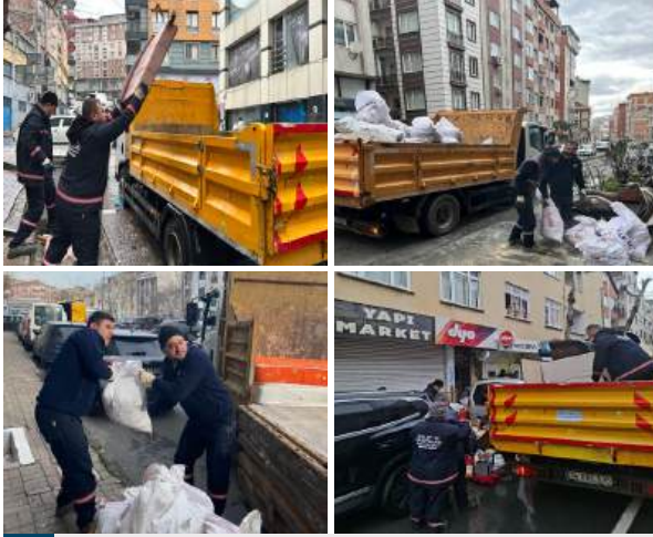
Eysel Eşya ve Tadilat Atıkları Toplama Çalışmaları
