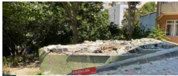
Metruk Bina Yıkım Çalışmaları
