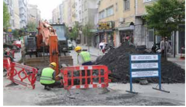
Yağmursuyu Kanalı Çalışması
