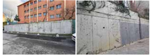
Betonarme Perde Yapım Çalışması
