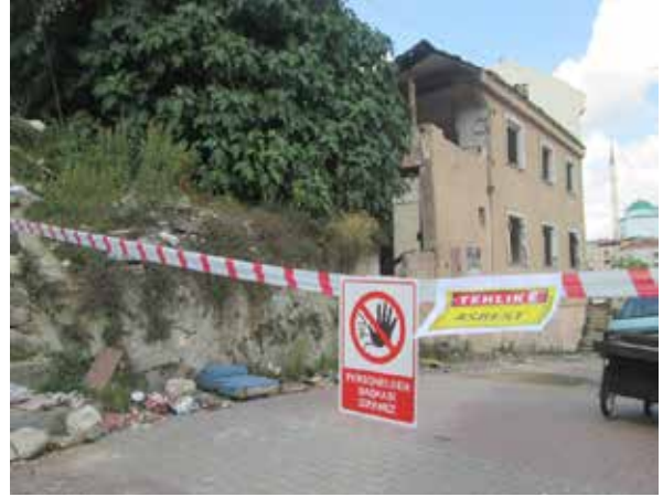
Asbest Söküm Çalışmaları
