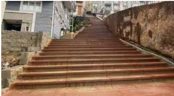
Merkez, Kıymetdar Sokak Merdiven Yapımı
