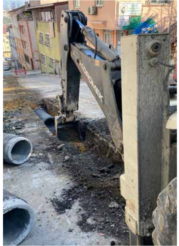
Yağmursuyu Kanal Çalışması
