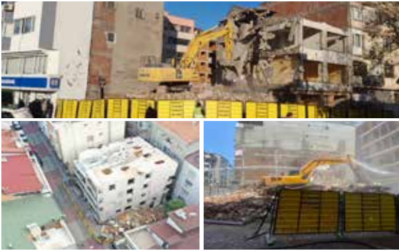
Riskli Yapı Tespit ve Yıkımları
