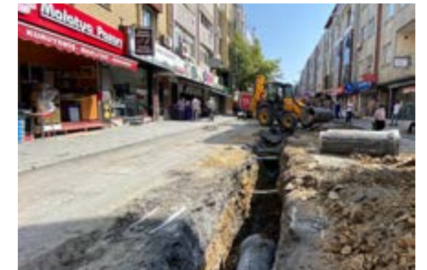
Yağmur Suyu Kanalı Yapımı Çalışması
