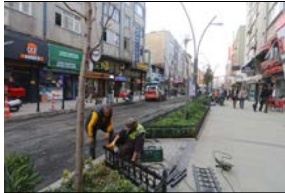
Yol Korkuluk Yapımı
