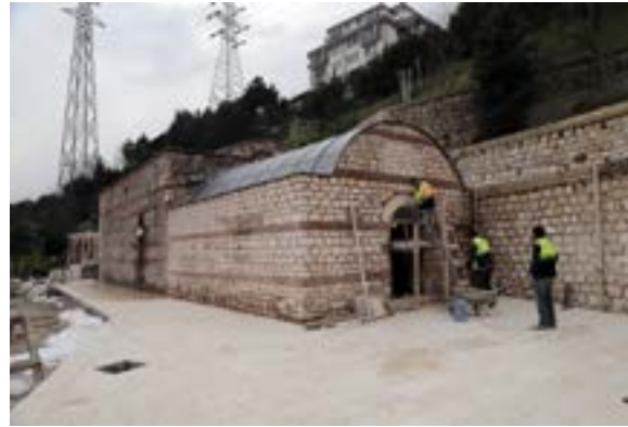
Tescilli Su Hazneleri Restorasyon Yapım işi
