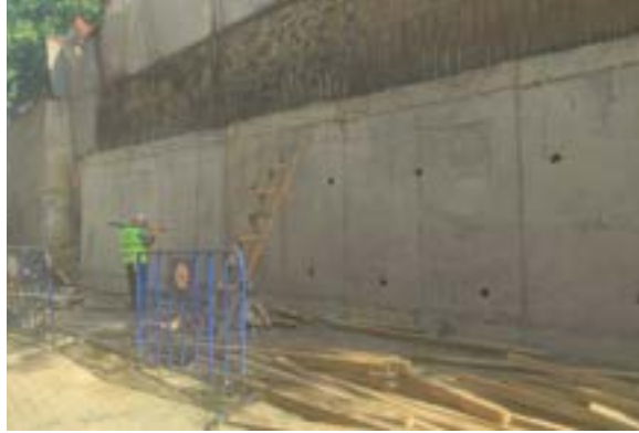
Betonarme İstinat Duvarı Yapım Çalışmaları
