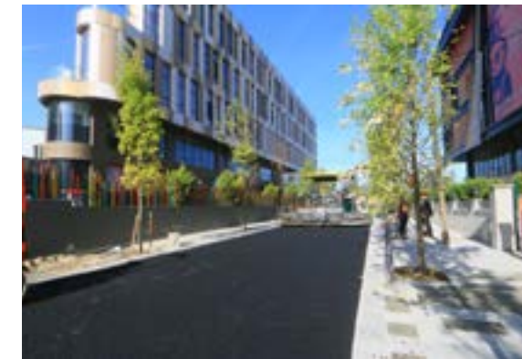
Meydan Projesinde Asfalt Kaplama Çalışması
