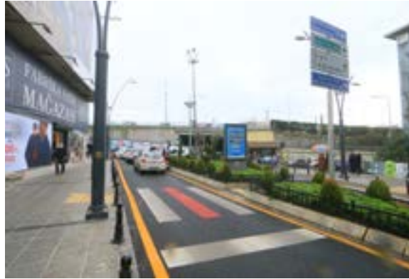
Gürsel Mahallesi 28 Nisan Caddesi Tematik Cadde Yol Düzenlemesi
