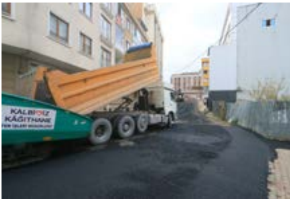
Asfalt Kaplama Çalışmaları
