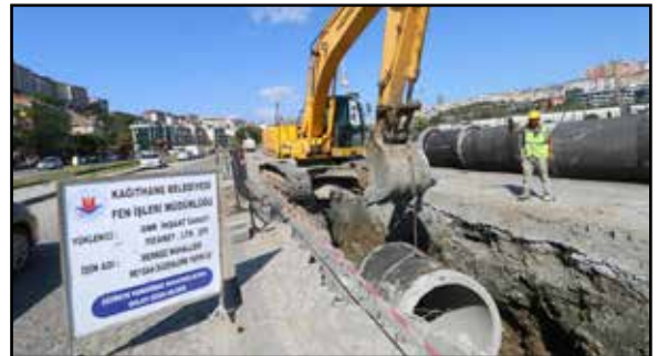
Yağmursuyu Kanal Çalışması
