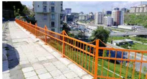
Yol Kenarı Korkuluk Düzenleme Çalışması
