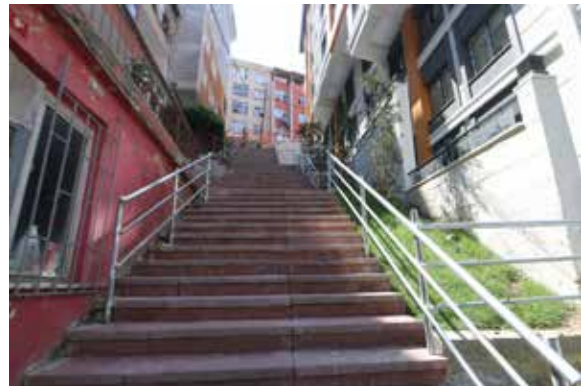
Gürsel Mah. Gülay Sok. Merdiven Yapımı Yeni Hali
