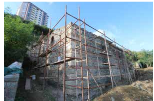
Tescilli Su Hazneleri Restorasyon Yapım İşİ
