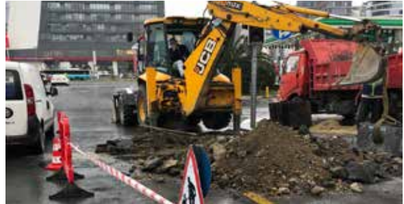
Yağmursuyu Kanalı Çalışması
