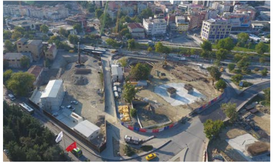
Kağıthane Merkez Metro Hattı Çalışmasının Havadan Görüntüsü
