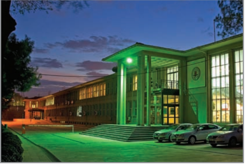
Kağıthane Belediye Başkanlığı binası 2008.
