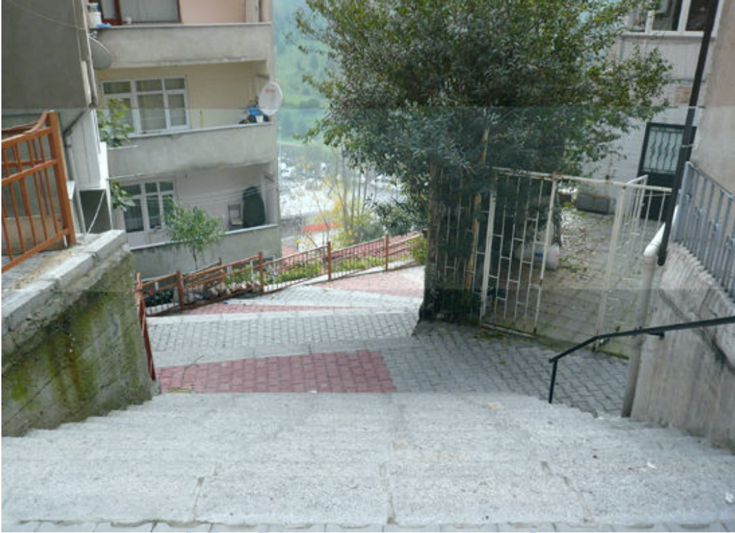
ORTABAYIR MAHALLESİ KARDELEN SOKAK
