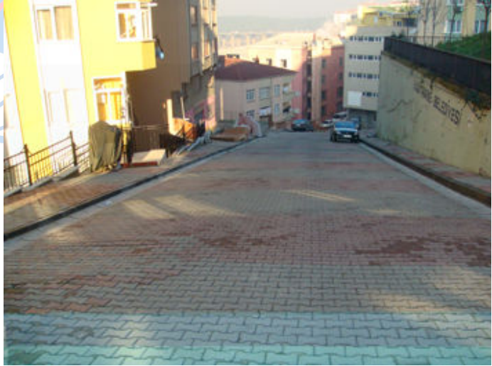
SEYRANTEPE MAHALLESİ GÜL SOKAK
